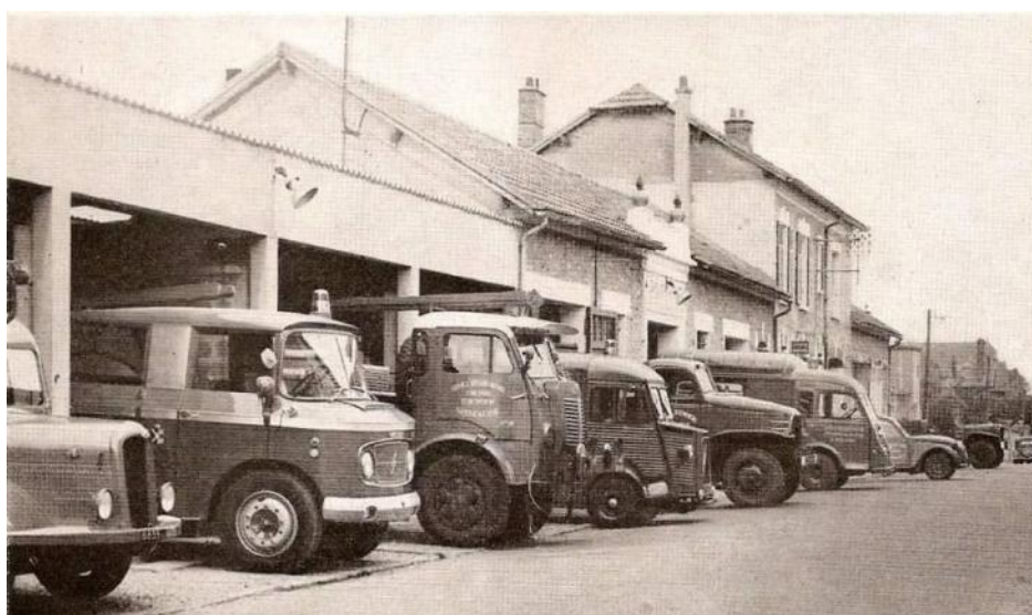
le matériel roulant du centre de secours de la rue Dubuc. cliché Mairie 1961
