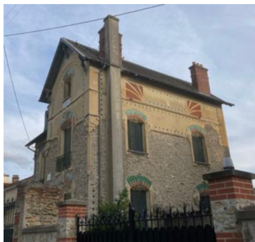
pignon ouest, cliché Pierre
