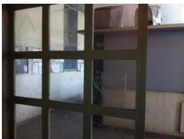
Vue de l'intérieur de la cellule pour mineurs
