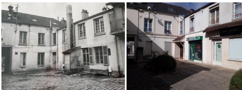
La cour, côté rue de Gaulle, avant et après travaux
