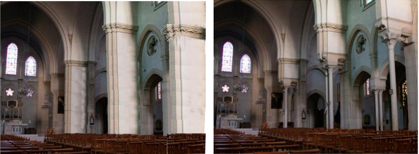
A gauche, j'ai fait une simulation de l'église avec des piliers traditionnels, à droite option retenue, avec piliers en fonte
