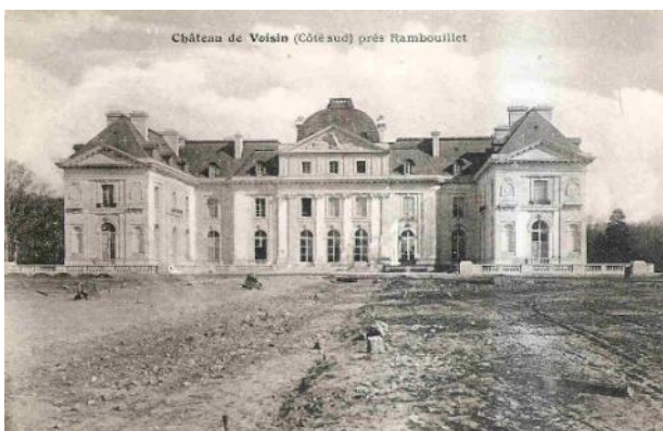
la façade sud, à la fin du chantier
