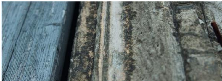
Restes de plusieurs couches de peintures dans une moulure abritée d'un encadrement de baie, Source : Tiffanie Le Dantec
