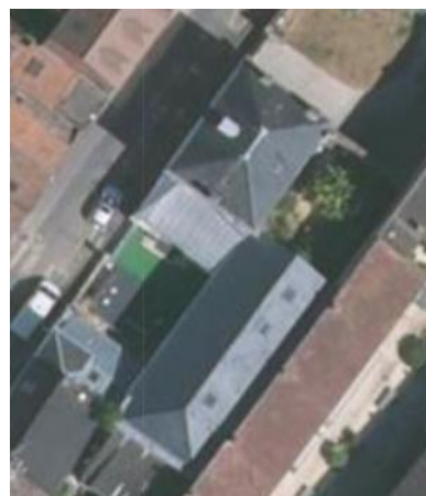
vue actuelle des bâtiments
