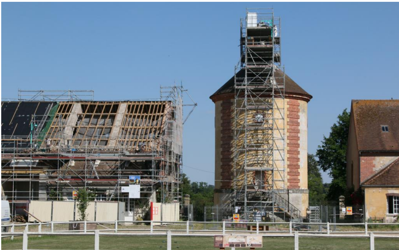
Etat des travaux au 1er juillet 2020
