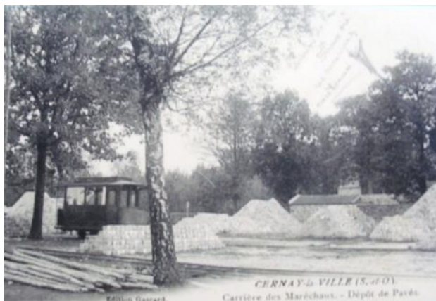
les pavés sont stockés le long de la voie
