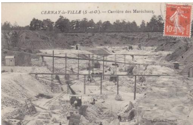
la carrière : les plans inclinés et la voie ferrée
